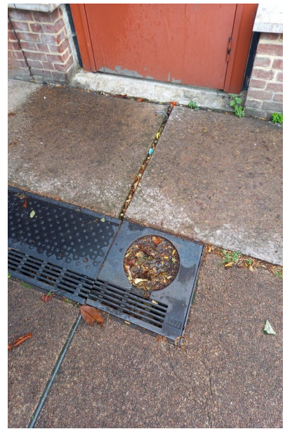
Illustration 19: Caniveau bouché
