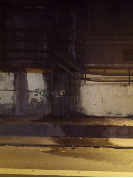
Illustration 17: Fuite d'eau dans le tunnel
