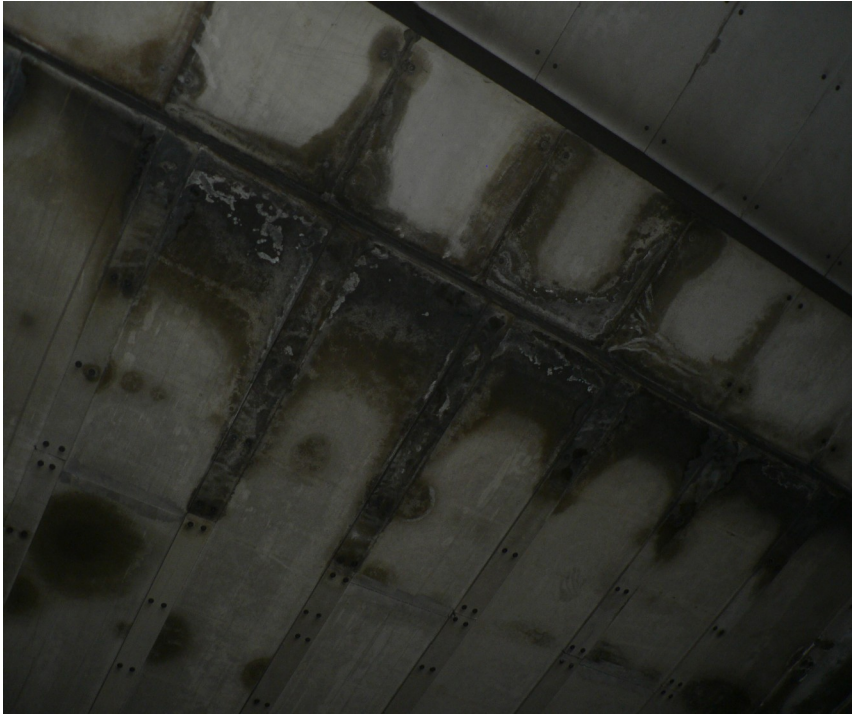
Illustration 3: Trace d'eau au plafond au niveau d'un joint transversal
