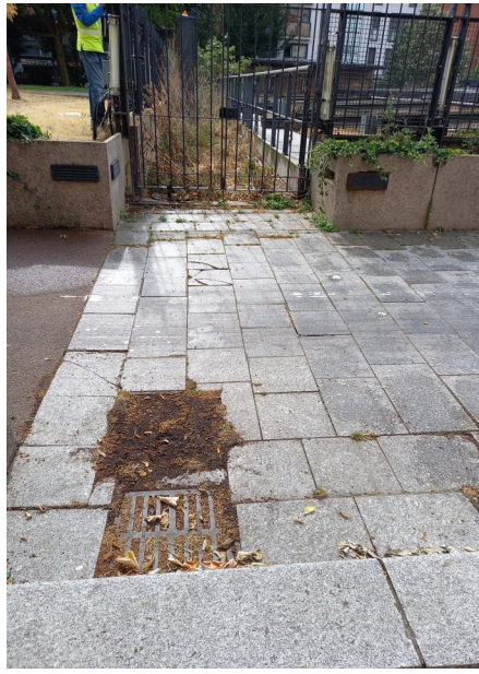
Illustration 18: Caniveau bouché
